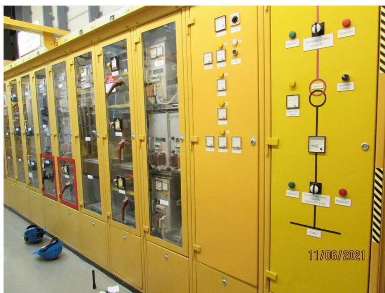
A 0,4 kV főelosztó mezői
